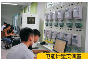
电能计量实训室
